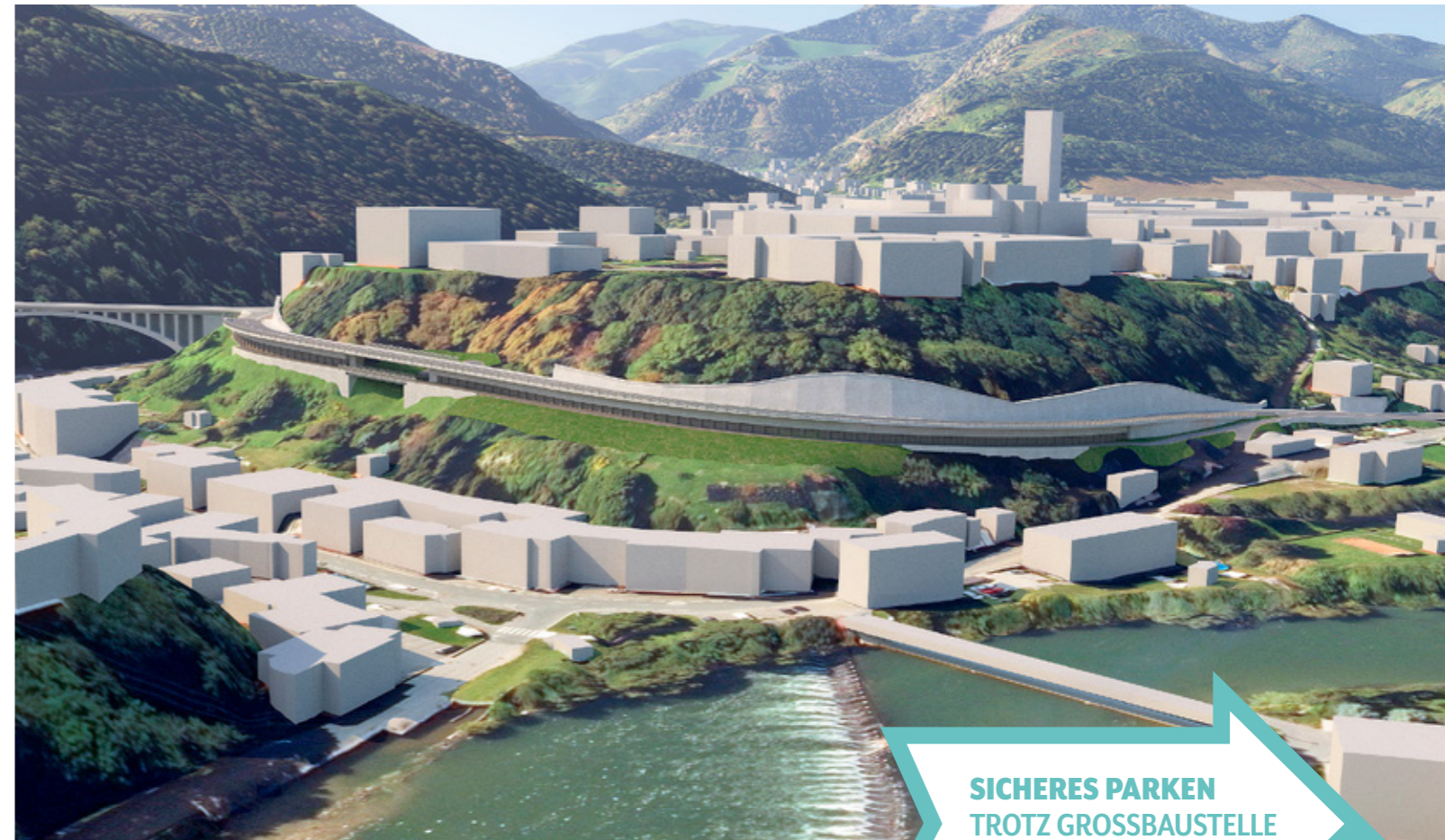
Das Land Steiermark investiert zehn Millionen Euro in die Sanierung der Rampe Landtorberg.
